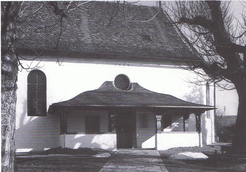
Vordächlein beim südlichen Kircheneingang
